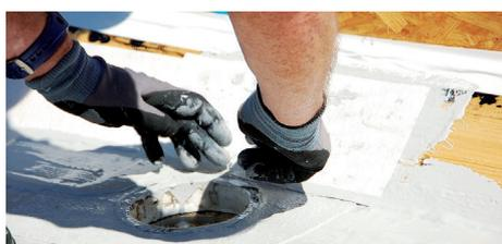
Pour effectuer un travail propre penser à protéger les détails avec des rubans adhésifs fixés sur la surface initiale. Penser également à protéger les détails, siphons, remontées, lès en hauteur. Selon les recommandations et règles professionnelles à hauteur de 15 cm.
